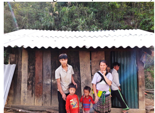
House after rebuilt (Ngôi nhà sau khi sửa)
